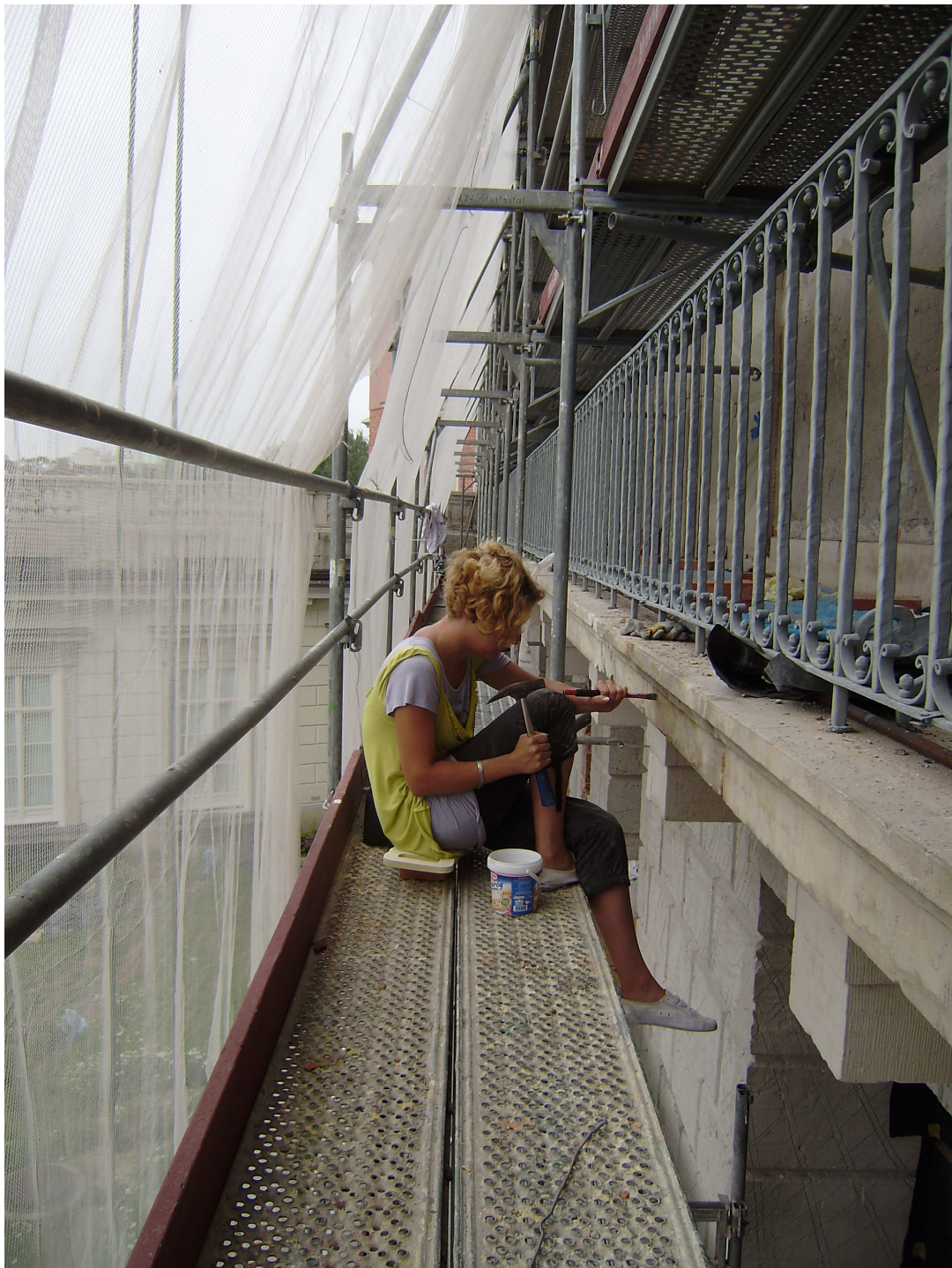
Konserwacja balkonu na elewacji gotyckiej
