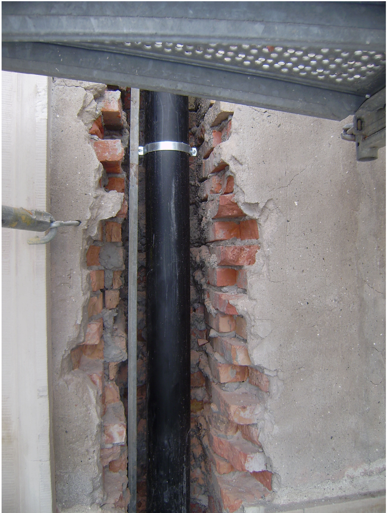
Odslonięta kanalizacja deszczowa
